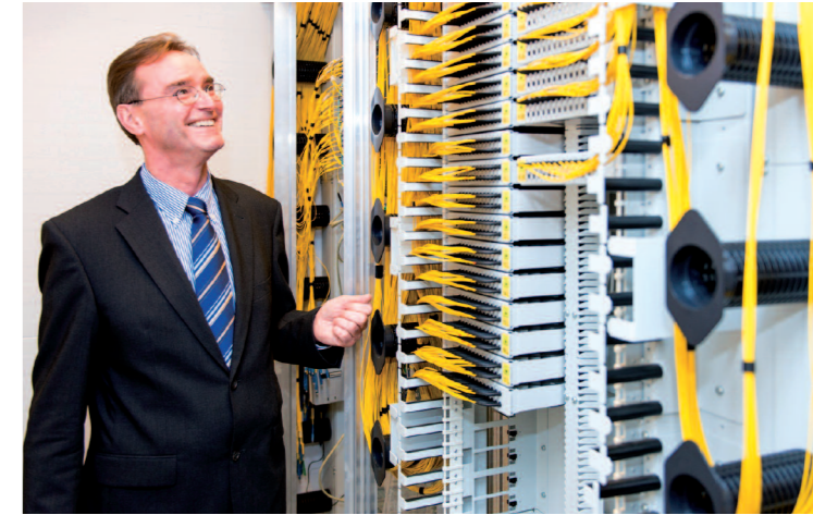
eFOS-Glasfaserverteilsystem für passive optische Netze
