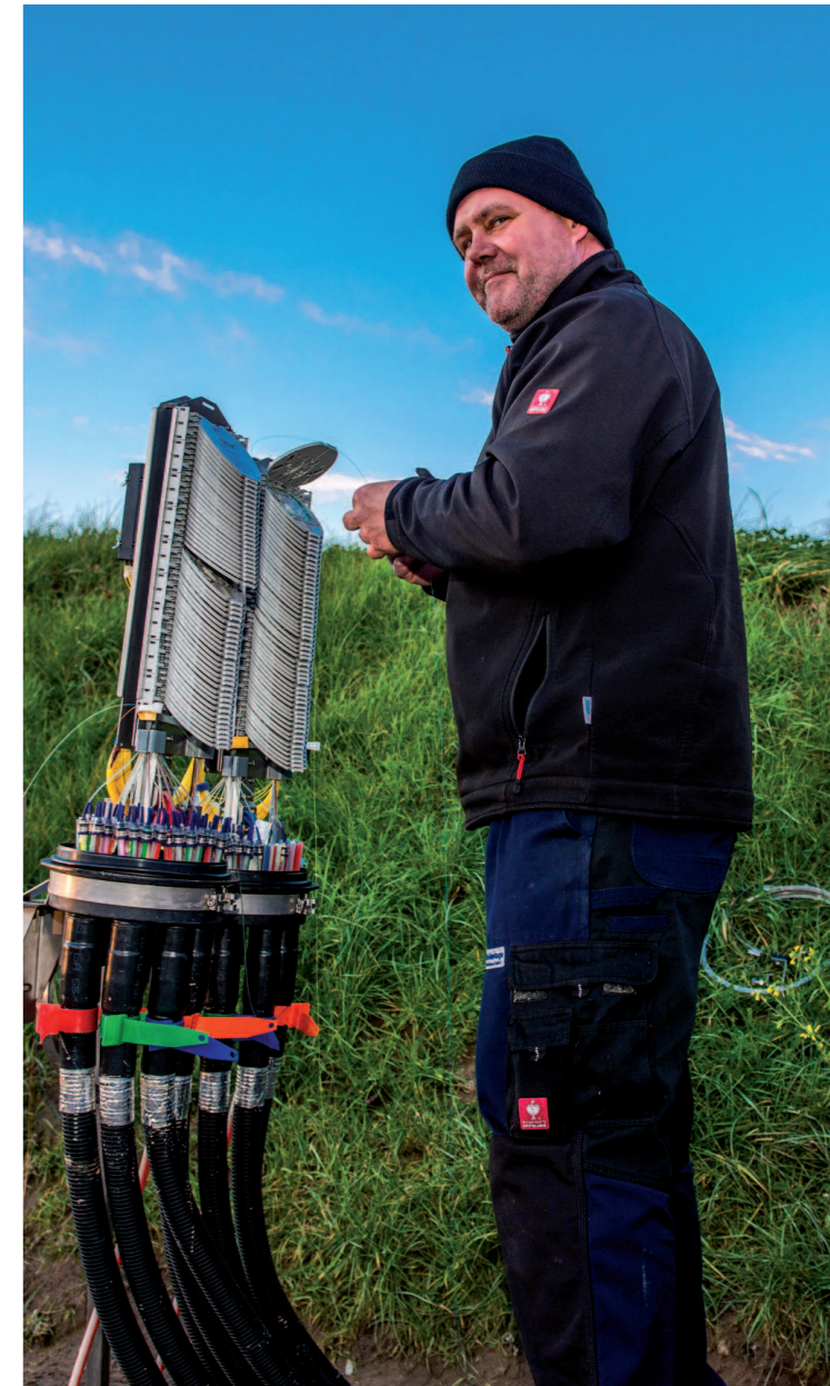
Monteur beim Spleißen an der Muffe
