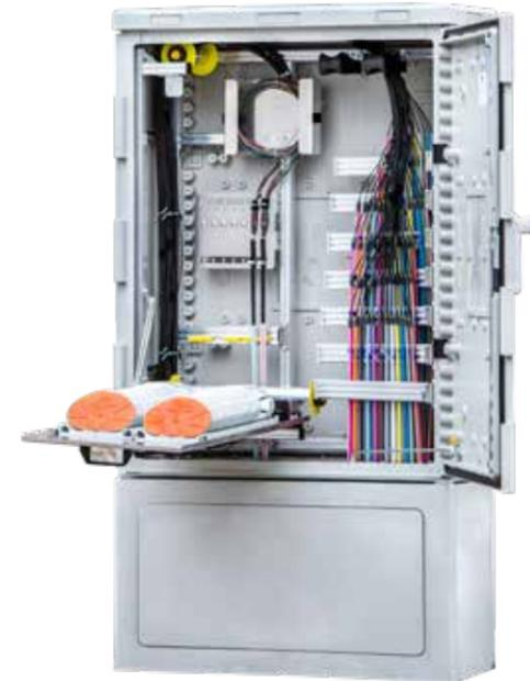
Das Einbauset für den Kabelverzweiger KVZ 08s3 ist speziell für die Anwendung im FTTx-Umfeld designt und beinhaltet ein Kabelmanagement für ankommende Kabel, ein Rohrmanagement für abgehende Kabel, eine Bündelader- und Kabelführung und ein klappbares Spleißmanagement.
